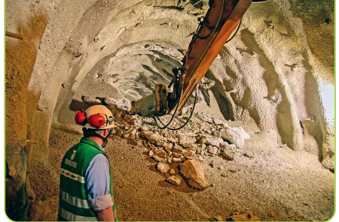
La excavación de la galería de rescate sirve como guía para la construcción del Túnel principal.
